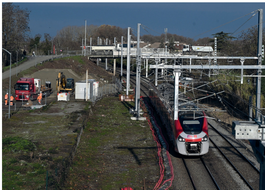
LGV Toulouse-Bordeaux-Dax dont les travaux se terminent en 2034 - ©Rémy Gabalda
